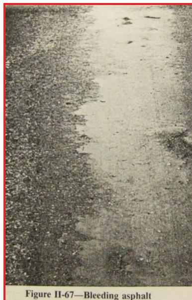
Figure II-67—Bleeding asphalt
