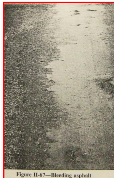
Figure II-67—Bleeding asphalt
